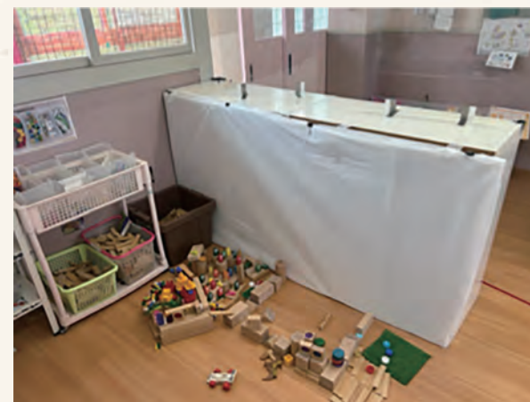
▲コーナーの棚の裏側に吸音材を貼り、おもちゃの響きを抑える
