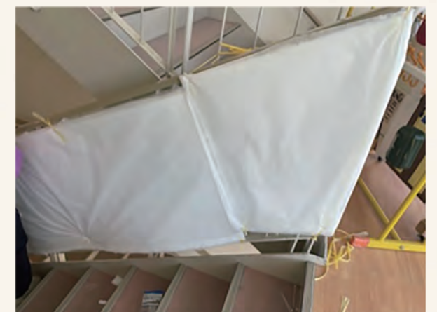
▲階段の手すりに吸音材を付けて上下の音の通りを抑える
