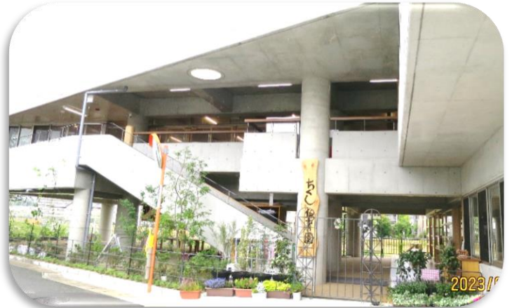
筑紫保育園本園 令和5年5月竣工の新園舎 入口の風景
